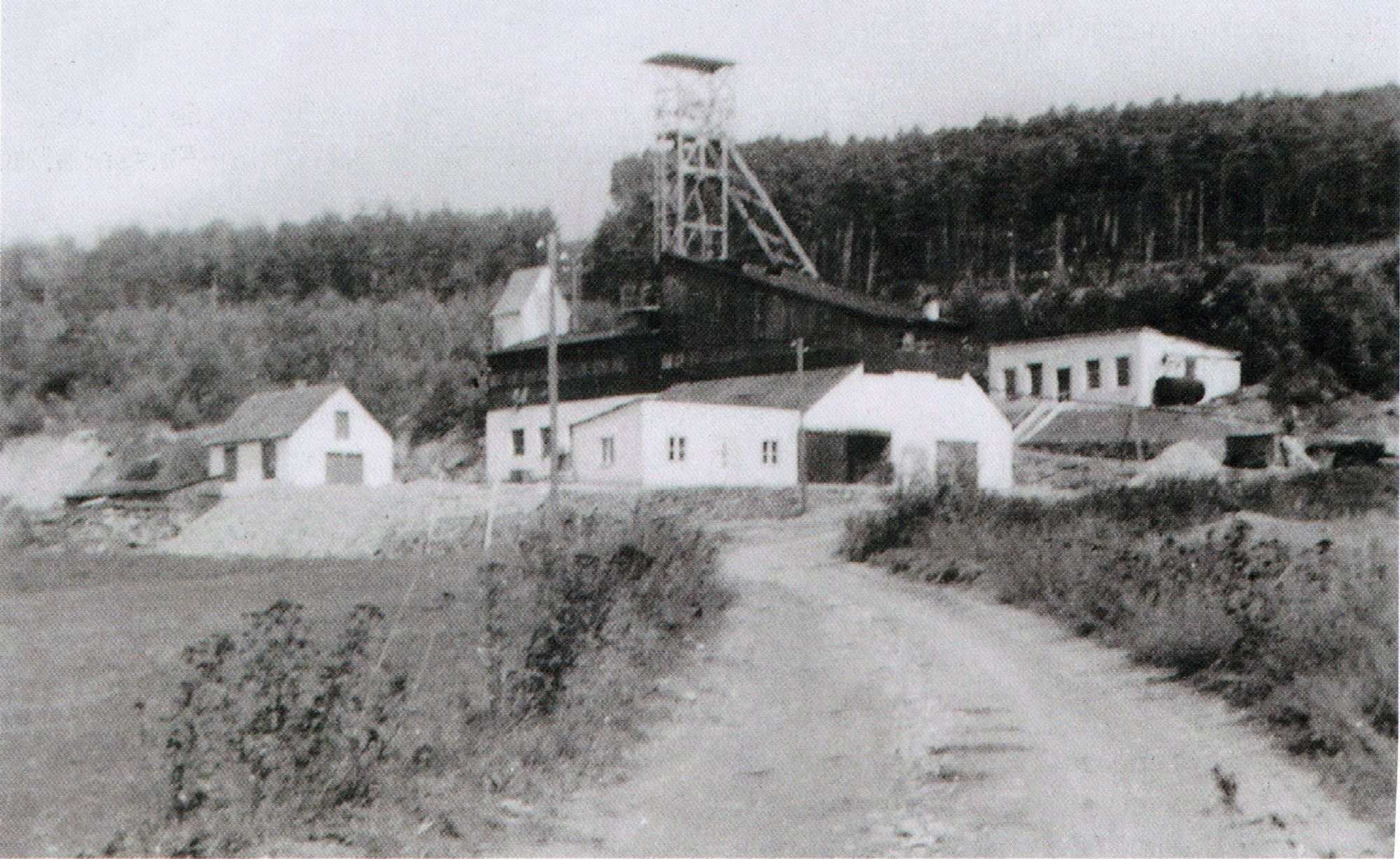
Der Johannesschacht war ein imposantes Bergwerk, in welchem bis auf 115 m Teufe Flussspat gewonnen wurde und der auch durch seine Uranführung bekannt war (Quelle: Archiv Koller)
